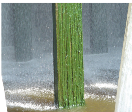
Рис. 3. Плівка водоростей на опірах градирні (АЕС Моховце)
