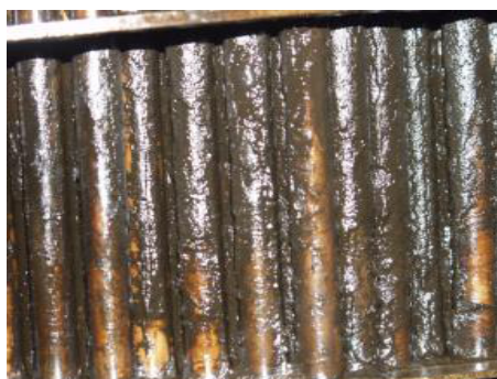
Рис. 5. Біоплівка на внутрішньої поверхні теплообмінника – споживача СТВ (Рівненська АЕС)
