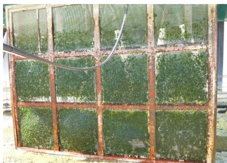
Рис. 1. Забруднення водяних сіток СТВ водоростями (АЕС Моховце)
