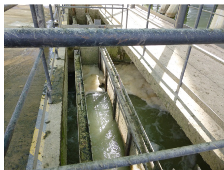
Рис. 6. Біоплівка (слиз) на поверхні обладнання (АЕС Козлодуй)
